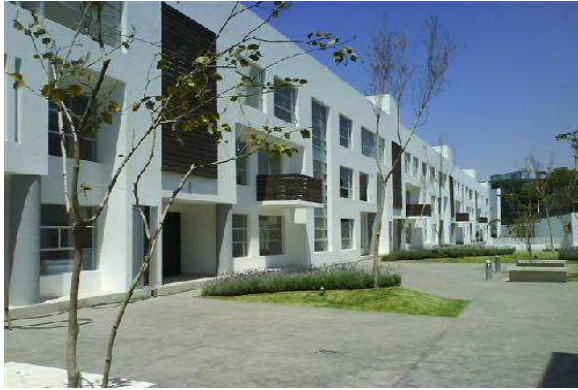
Instalaciones para hospedaje.
